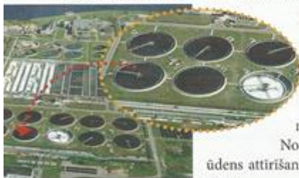
Nostādināšanas baseins Rīgas notekūdeņu attīrīšanas iekārtās
