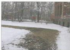
Nepietiekamas siltumizolācijas dēļ virs siltumtrases sasiļst augsne.
